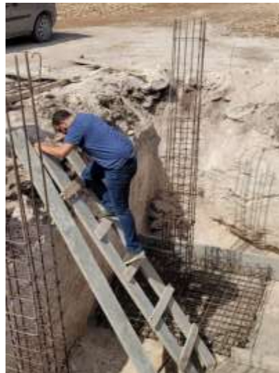
Ferrailage de la fondation du Château d'eau
