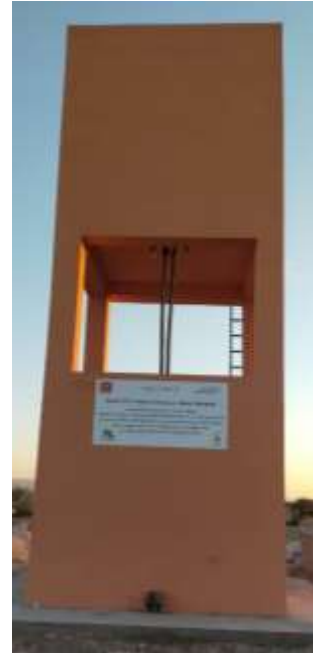
Château d'eau avec panneau
