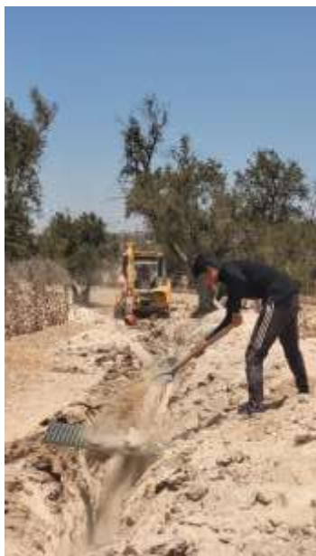
Tamissage de protection de la canalisation
