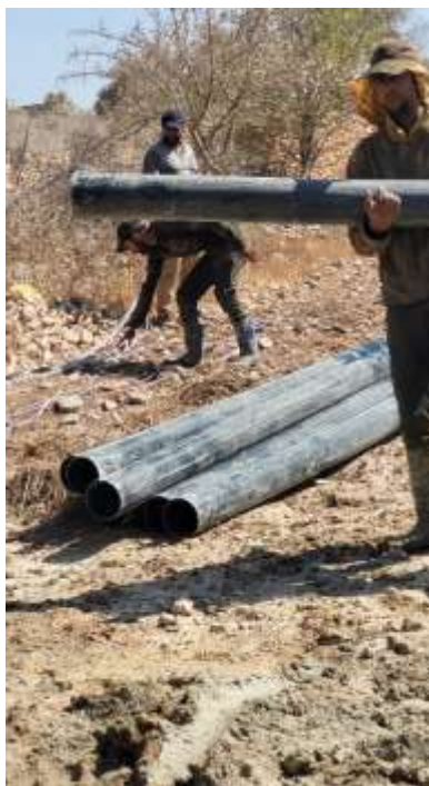
Pose du tubage
