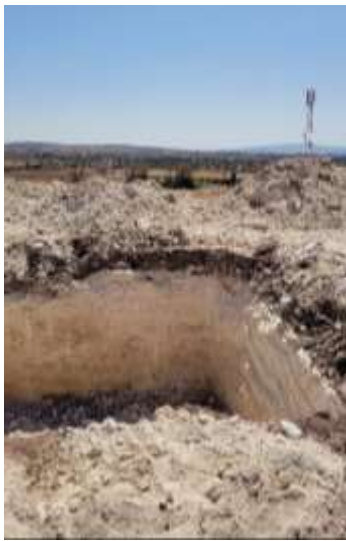
Préparation de la fosse pour prélèvements géotechniques
