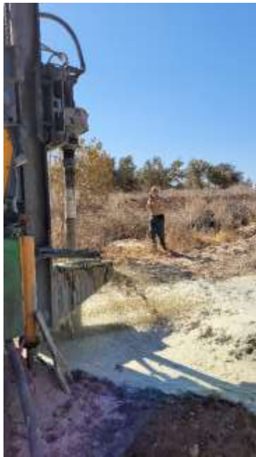
Traversée de la nappe captive à 65 mètres
