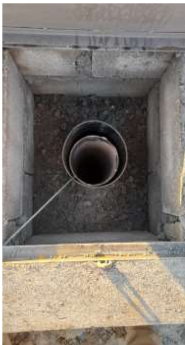
Protection du forage
