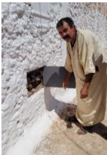
Installation d'un compteur par la Commune
