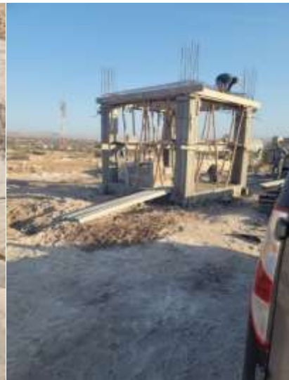
Le Château d'eau sort de terre
